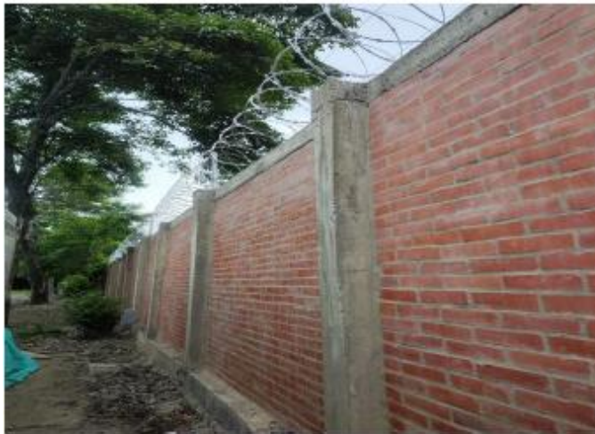
COLUMNAS Y VIGAS
